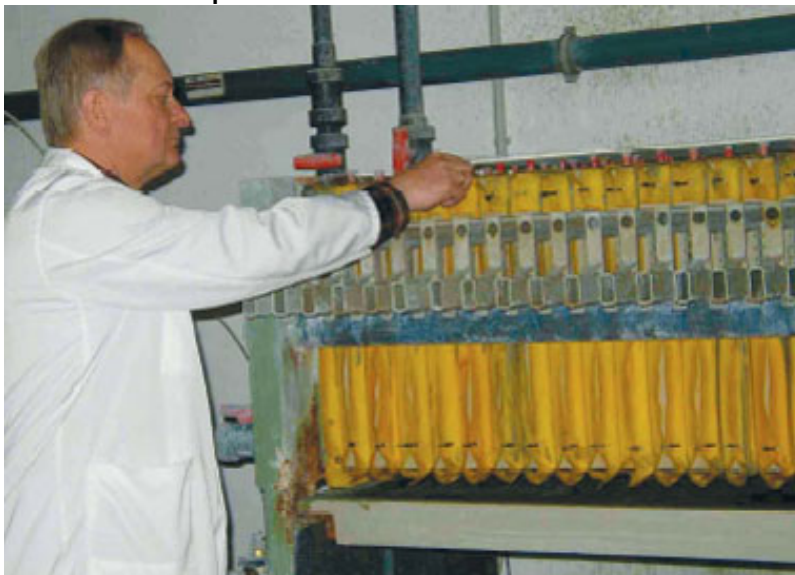
Bild: Kammerfilterpresse für Galvanikabwässer
