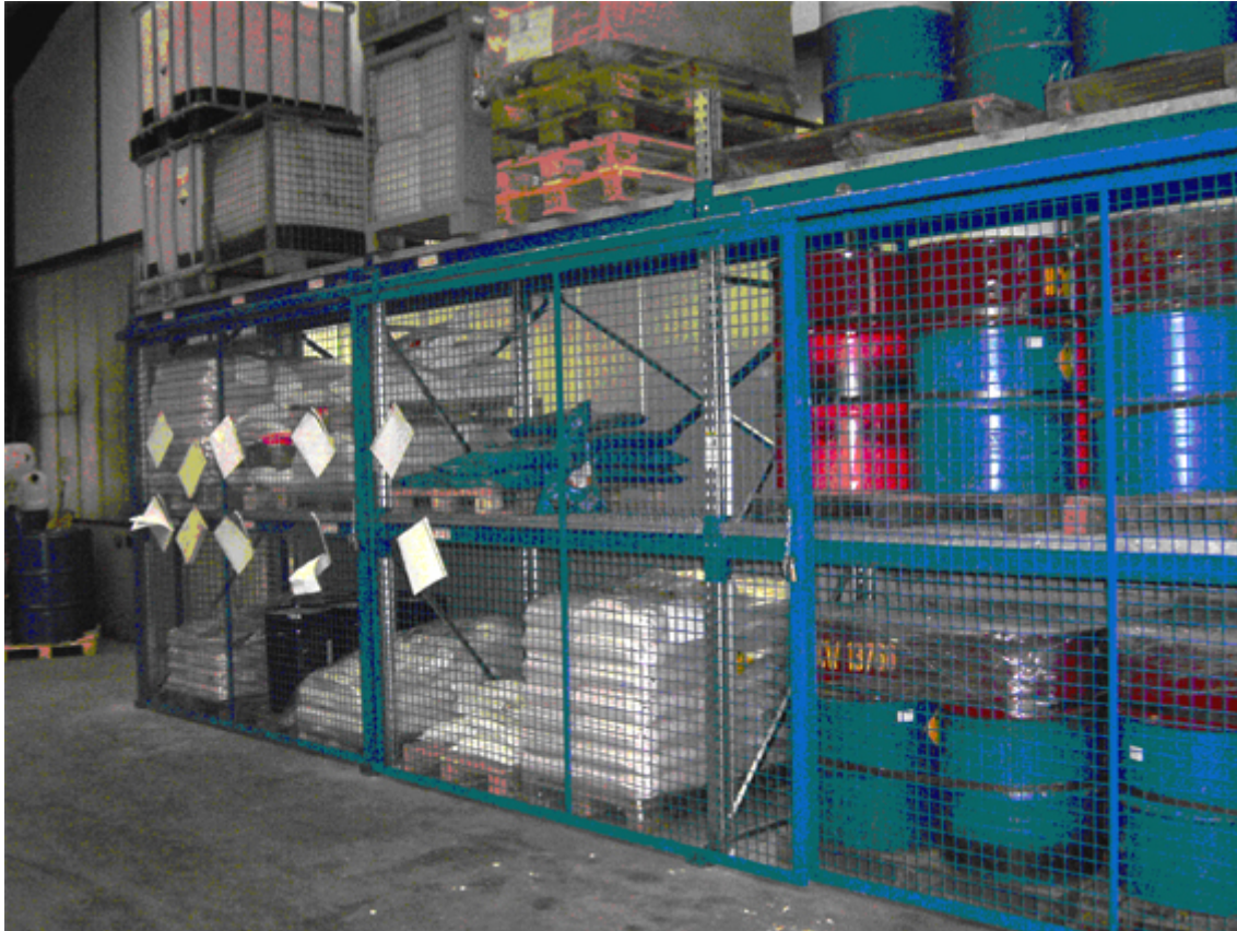
Bild: Gesichertes Gefahrstofflager für Prozesschemikalien
