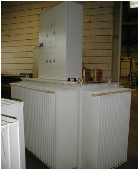
Bild: Gleichrichter in einer Galvanik
