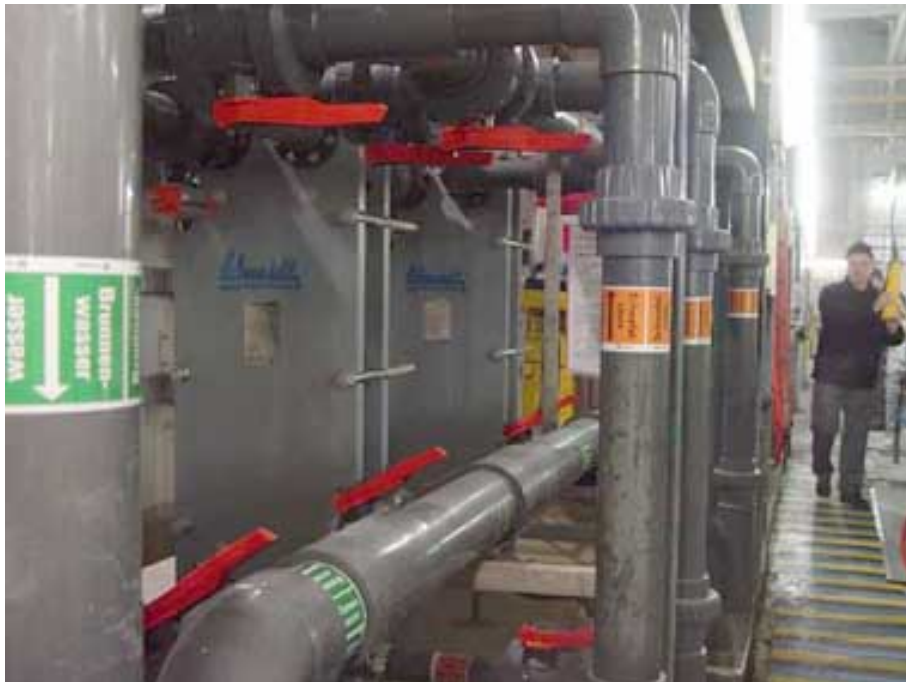
Grafik: Rohrleitungssystem zur Medienversorgung in einem Eloxalbetrieb
